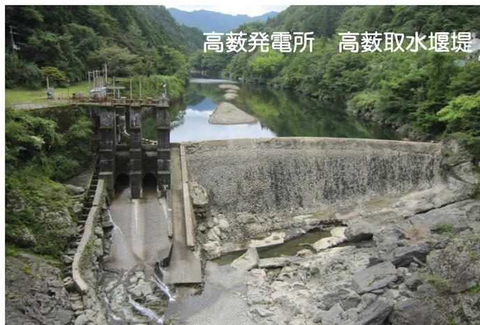
昭和5年に運転を開始した高菟発電所の取水堰堤。古い石積みを残す堤体は緩やかなアーチ形状を描きながら、部分的に自然の岩を取り込み、周囲の景観に溶け込んでいます。
